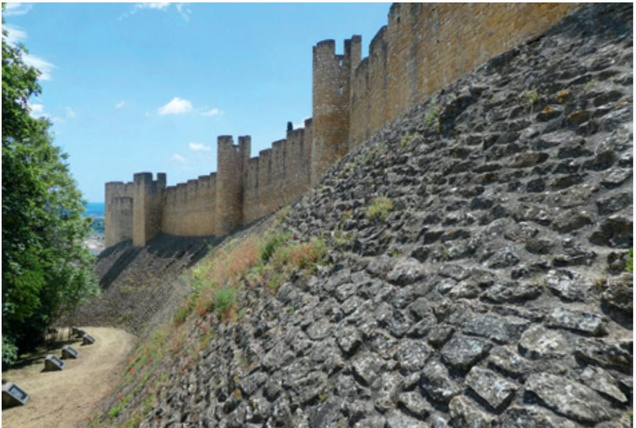
**Fig. 11** Tomar (Portugal). Vue d'un élément d'enceinte flanqué de tours en U et d'une tour quadrangulaire, avec leur talus rapporté.
