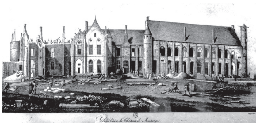
◀ Fig. 18 : Montargis. Vue de la façade nord-est après la première phase de démolition, dessin et lithographie Claude Motte (cl. Médiathèque du Patrimoine). On voit que le lanternon de la cloche de l'horloge a déjà été démonté.
