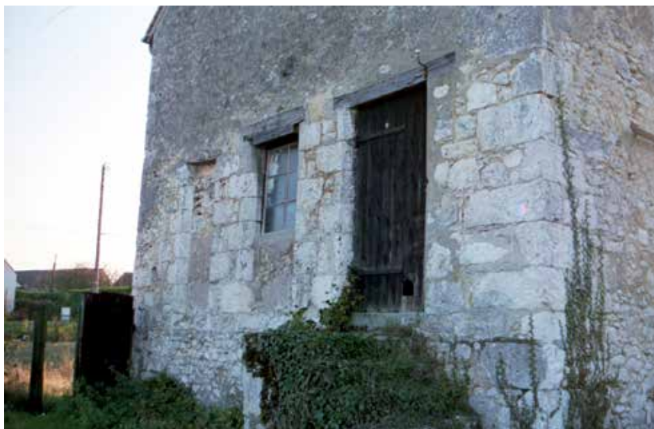
Fig. 6 - Le pignon nord-est de l'ancienne chapelle, avec son triplet de baies dont la partie supérieure a été ôtée et remplacé par des linteaux de bois (cl. JM 1989).
