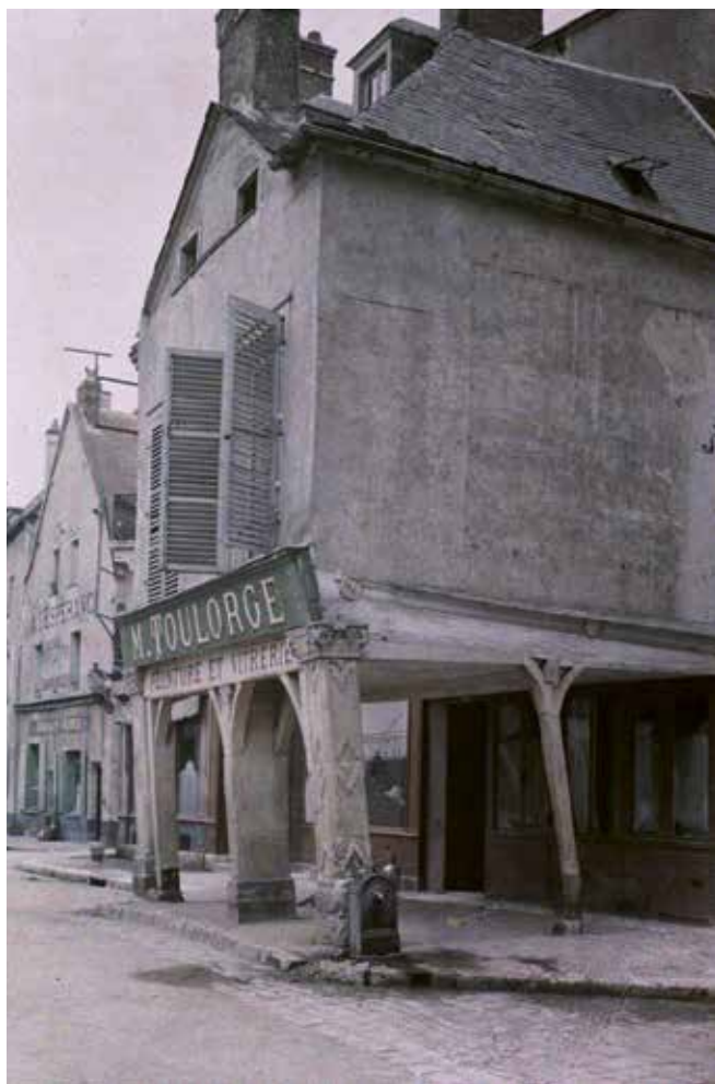
Fig. 10 - La « maison penchée » de la place de l'Étape au vin à Chartres (cl. Léon Auguste 1922, Musée Albert Kahn ; A 33781). Cette maison disparue donne une bonne idée de ce que furent être les « bretauches » de la place Saint-Ayoul, même si son couvert est sans doute plus saillant que celui de ces maison provinois.
