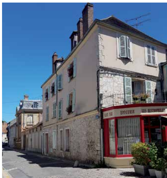
Fig. 14 - Vue de l'hôtel des Corchets, à l'angle de la rue des Barbeaux (actuellement rue Valentin Abeille) et de la Grande rue. Noter, sur la façade Grande rue, les traces des fenêtres et de la corniche médiévales (cl. JM 2022).
