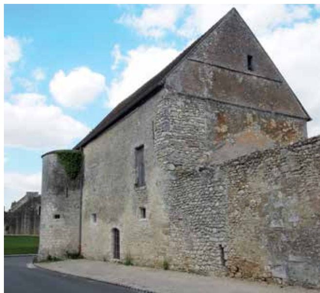
Fig. 5 - L'hôtel de la Madeleine, vu depuis le sud-est (cl. Thomas Clouet 2013). L'ensemble des baies (dont une murée à l'époque) est médiéval, mais les fenêtres du premier étage ont perdu leur meneau médian, et la plus proche a été agrandie en porte. Noter à l'angle du pignon les traces d'une porte défigurée en 2003, qui menait peut-être au comble, ainsi que le solin d'un grand bâtiment agricole moderne détruit à cette époque. On voit aussi la corniche qui ceinturerait l'ensemble du bâtiment, et une seconde corniche plus haute qui visait à amaigrir le mur.
