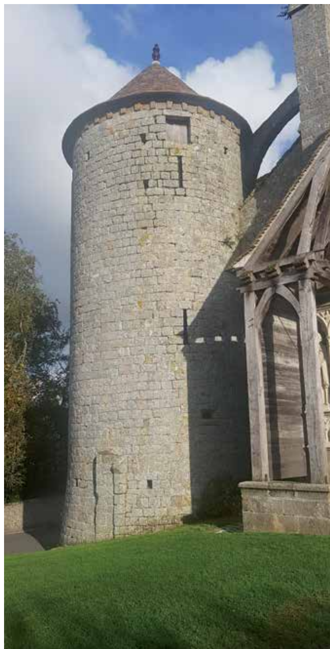
Fig. 7 - La tour située à l'angle nord-ouest de l'église de Rampillon, construite en même temps que la nef et le portail au milieu du xiii e siècle (cl. JKM 2022). Noter les ressemblances avec le « tournillon » de la Madeleine.
