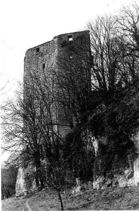
8. Vue de la tour maîtresse à éperon. Chaudenay-le-Château.
