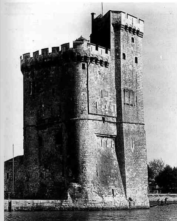
La Tour Saint-Nicolas de la Rochelle, bâtie dans le dernier quart du XIV e siècle. Noter la présence d'archères rasantes au niveau bas. Cliché Jean Mesqui.
