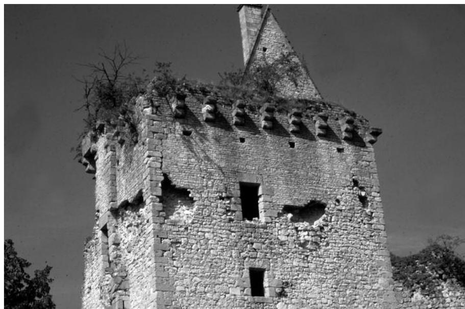
Fig. 17 - Bois-Sire-Amé, tour IX, face est avec reprise de maçonnerie.
