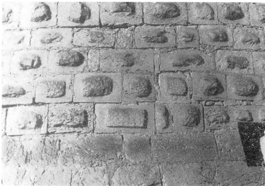
Fig. 10. — Parement à bossages rustiques à Grossouvre (Cher). On distingue nettement la marque des coups de ciseau : le bossage semi-rustique central, en bas, a été taillé en donnant une trentaine de coups de ciseau
