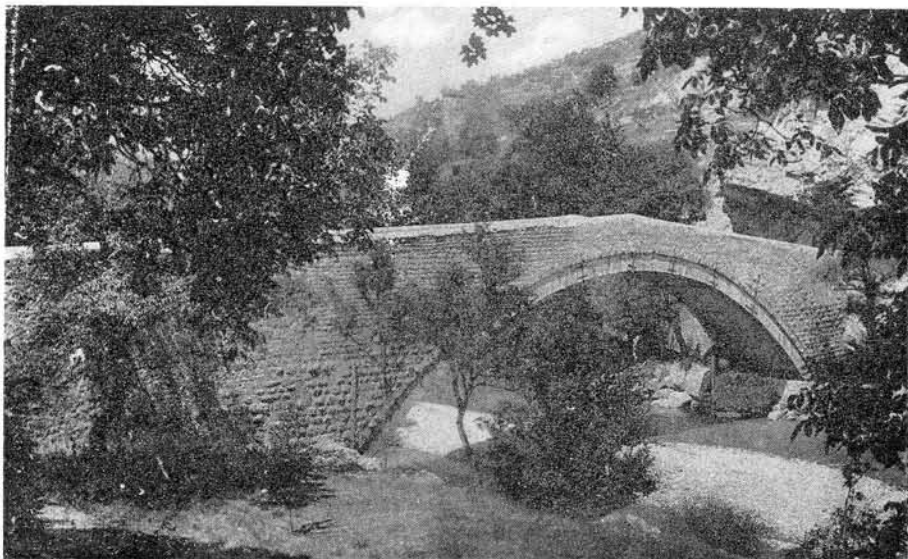
Fig. 9. — Pont de Castellane (Alpes-de-Haute-Provence) (d'après une ancienne carte postale).
