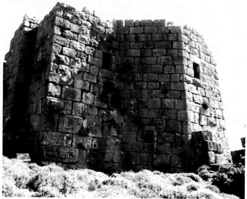
Figure 34 : Vue de la tour 21 prise depuis le sud-ouest.
