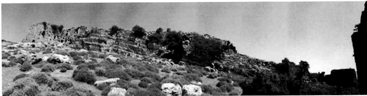
Figure 30 : La tour 4 et la courtine 4-18, vues depuis le sud.
