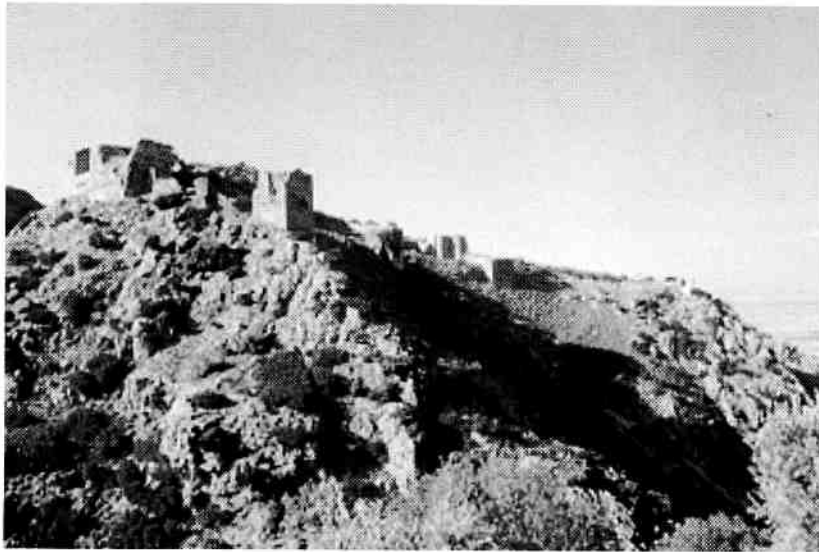
Figure 4: Vue de la forteresse prise depuis le sud-ouest (au premier-plan la tour 6).
