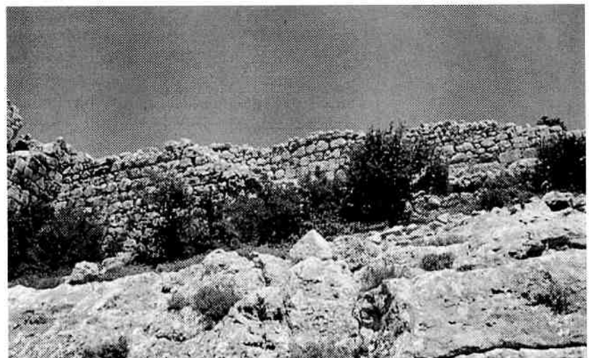
Figure 37 : La courtine 1-17 vue de l'ouest.
