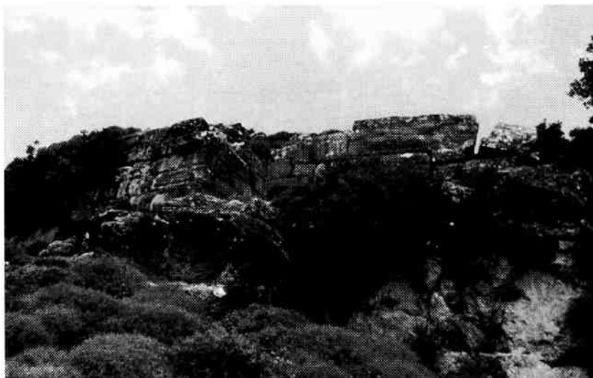
Figure 31 : Vue de la tour 18 et de son raccord avec la courtine 18-20.
