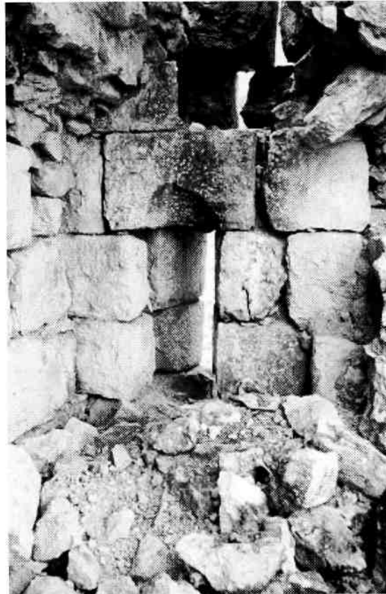
Figure 36 : Archère de la tour 35 dans un iwan.
