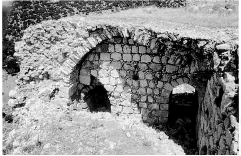
Figure 16 : Vue intérieure de la courtine 3-4, prise depuis le sud.
