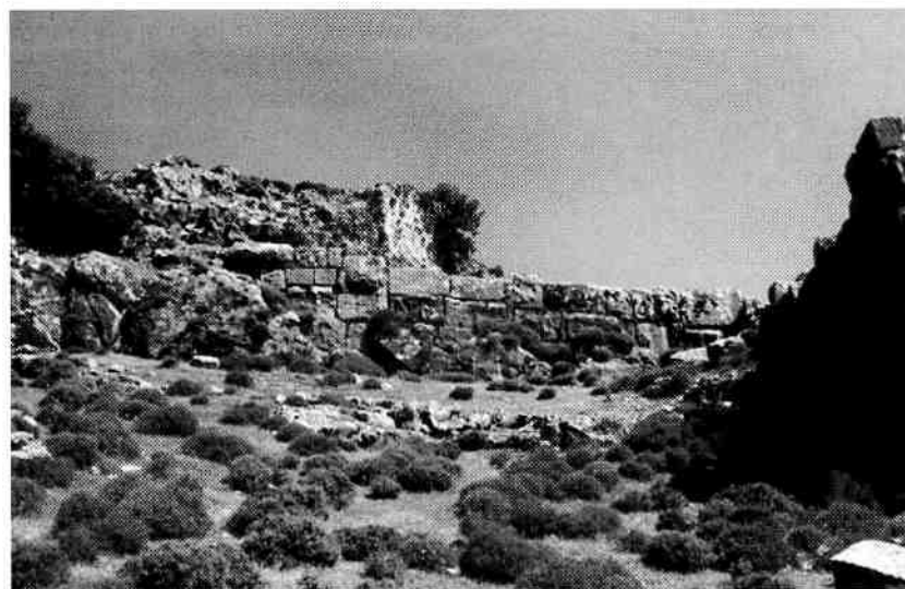
Figure 33 : Vue de la courtine 20-21 prise du sud. Derrière, la qulla.
