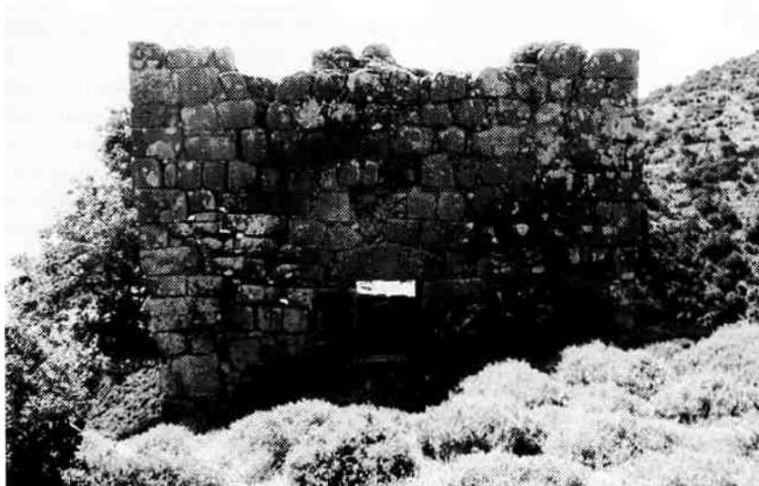
Figure 22 : Courtine 10-11 et la tour 12 au centre.
