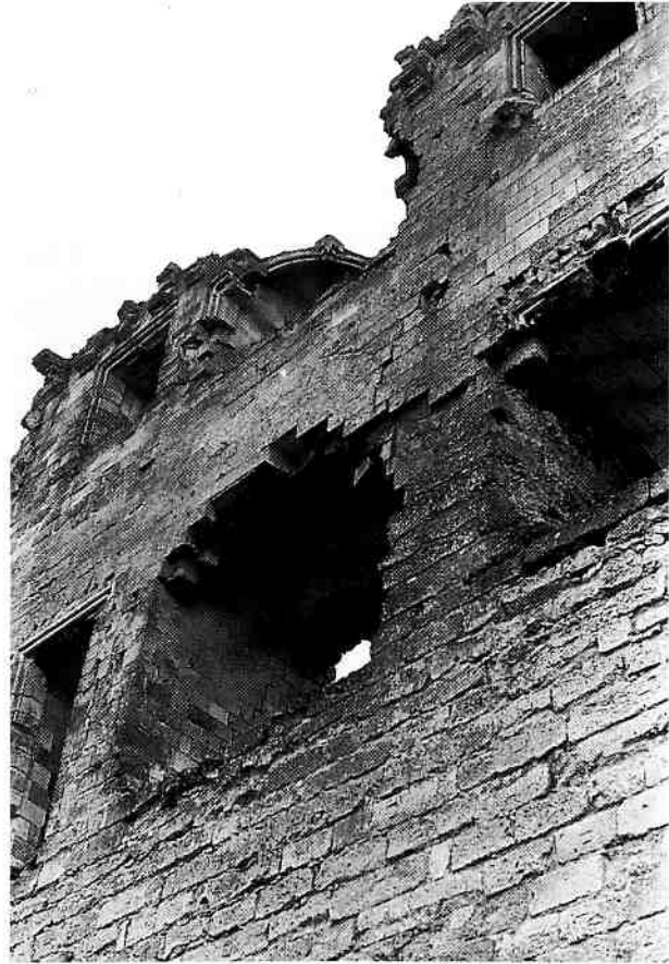
FIG. 11. — VUE ACTUELLE DE LA FAÇADE NORD-OUEST DU LOGIS, VUE DE L'EXTÉRIEUR
