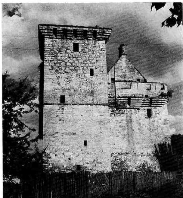
FIG. 19. — CROUY-SUR-OURCQ. LE DONJON ET LE LOGIS, VUS DU NORD-OUEST On remarquera les curieux mâchicoulis, ainsi que les archères, dans le chemin de ronde du logis
