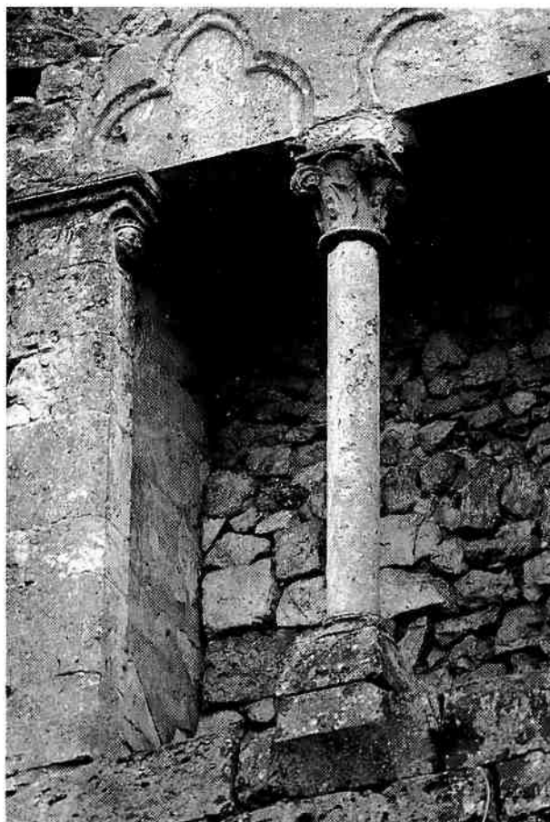
FIG. 6. — DÉTAIL DE LA FENÊTRE MÉDIANE DE LA FAÇADE NORD
