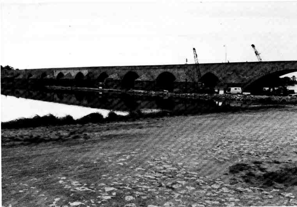
Vue générale du chantier avec digue d'accès et de protection
