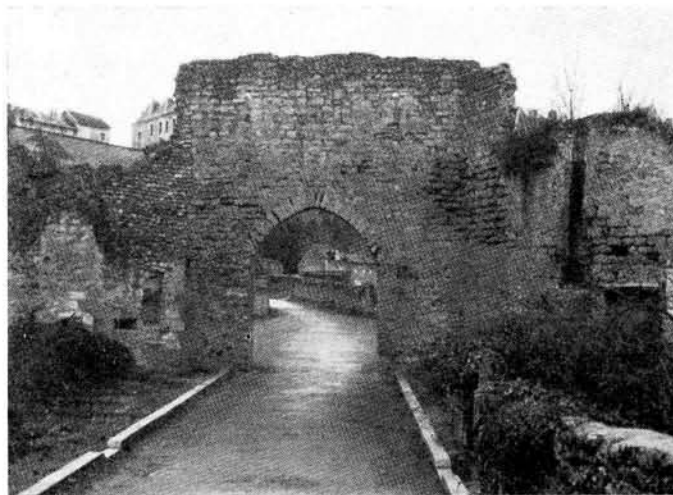
Portail d'entrée du châtelet de tête de pont à Thouars
